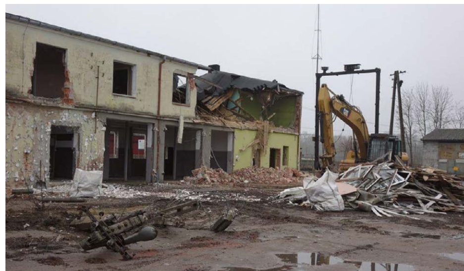
Prace rozbiórkowe przy SKR
