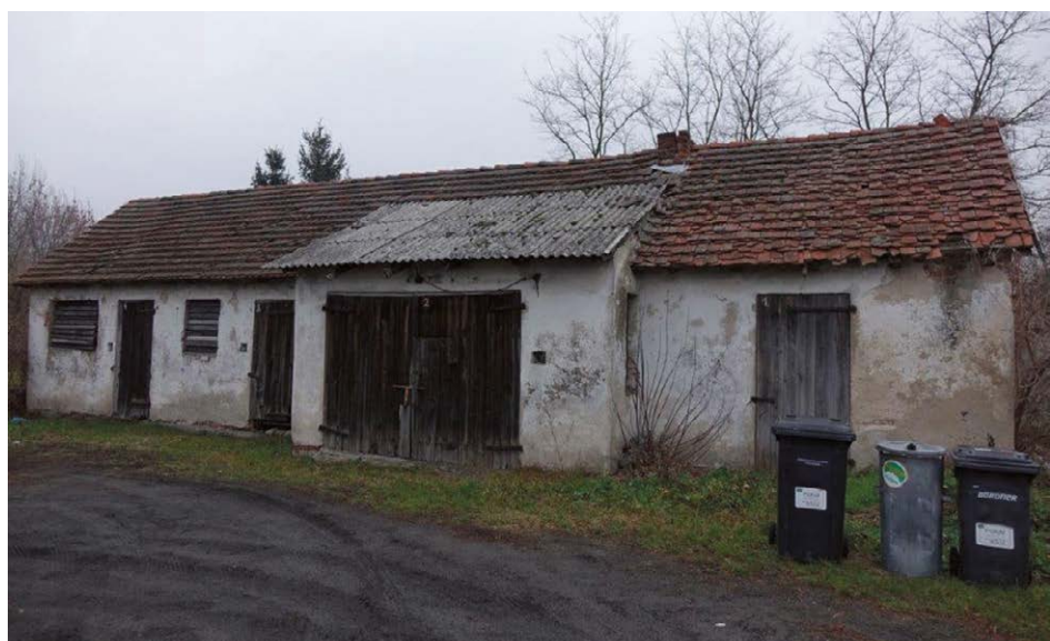
Budynek gospodarczy przy Ośrodku Zdrowia w Grodźcu
