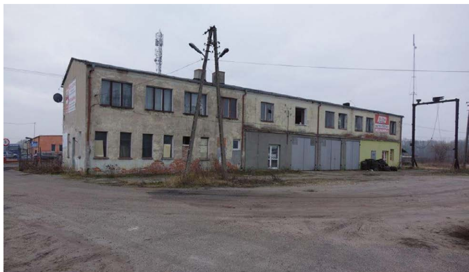
Biurowiec SKR-u przed rozbiórką
