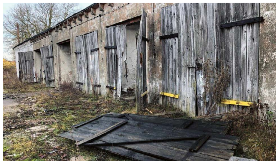
Stan pozostałych budynków SKR-u przed rozbiórką
